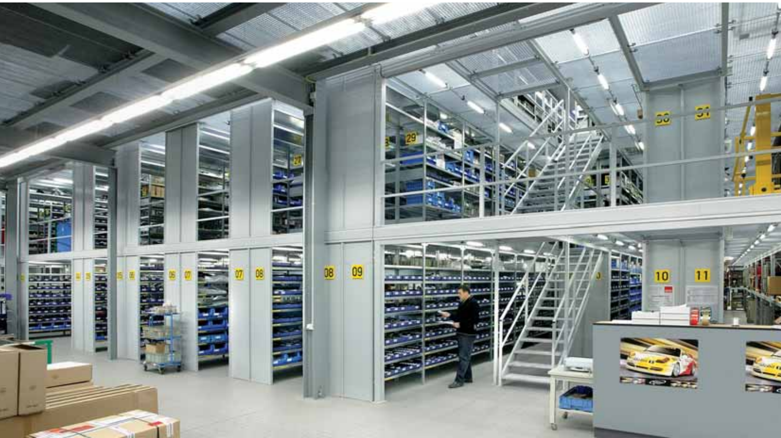
3-patrové skladové zařízení v automobilním průmyslu
